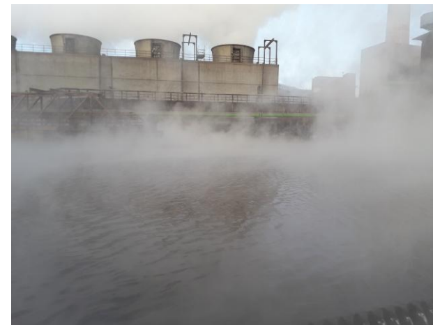
Bild 1: Wärme des Gaswaschwassers wird durch Verdunstung an die Umgebung abgegeben
